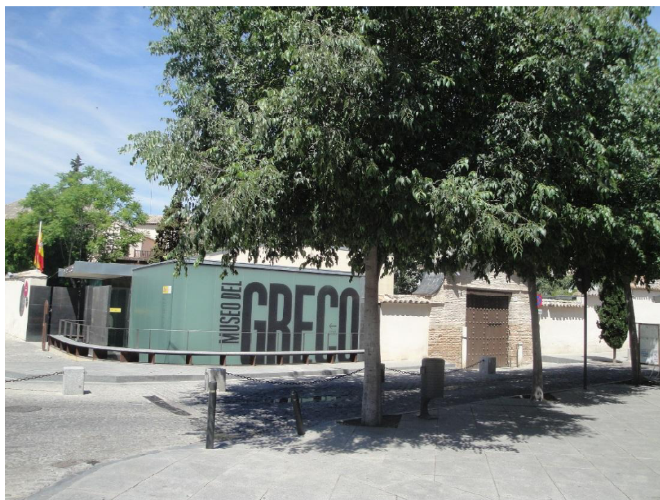
3. El cubo acristalado situado en el segundo jardín y en el muro de cierre donde se han instalado la taquilla y otros servicios.
