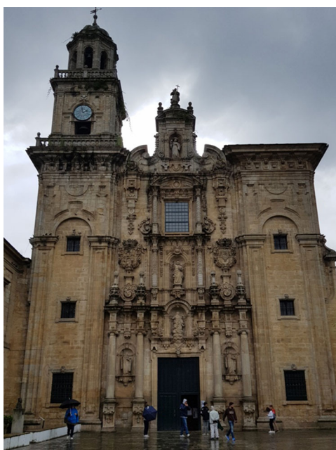
10. Fernando de Casas y Novoa. Fachada de la iglesia . Hacia 1735. Monasterio de San Salvador de Vilanova de Lourenzá (Lugo).
